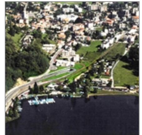
Fig. 13 - L'accès à la galerie de la contournement (Comune di Agno, 1998)
